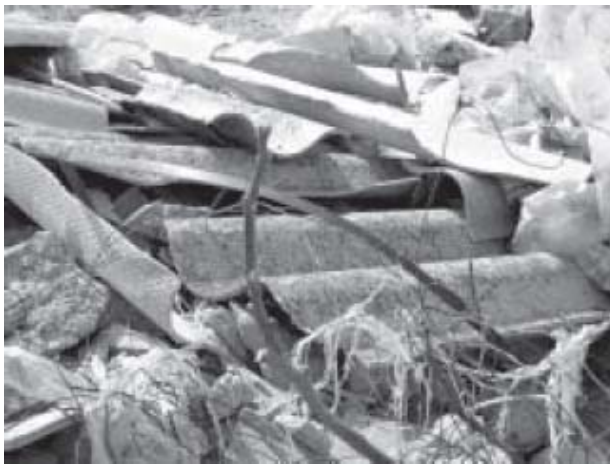
Figura 5 Exposición laboral: retirada placas fibrocemento
