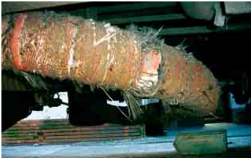
Calorifugado textil.
