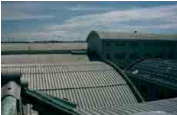
Cubierta de fibrocemento.
